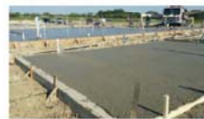
Concrete pour on model homes site
